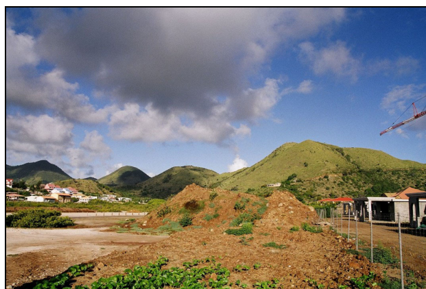
Photo 24 : Remblaiement : Tas de terre prêt à être étalé sur les bosquets de mangrove à gauche.
