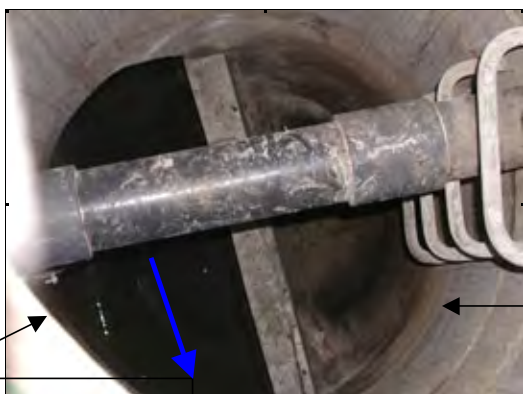
Déversoir amont après travaux de réhaussement du seuil de déversement en béton – photo CFD 20 mai 2009
