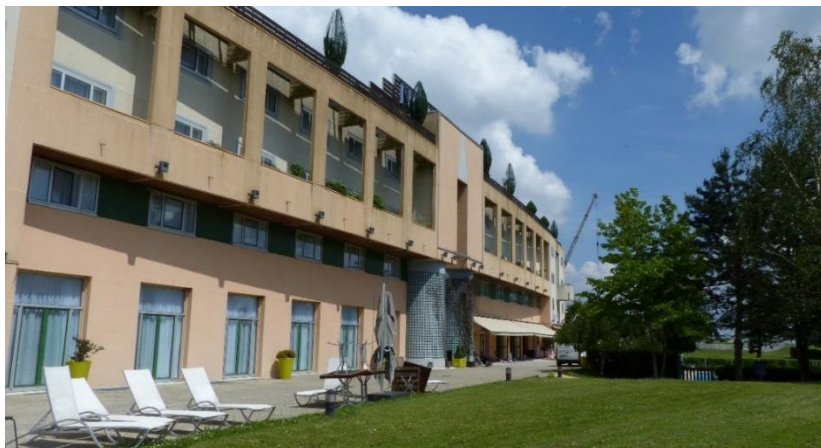
Figure 105 – Bâtiment du Novotel situé au nord du golf © O. Roquinarç'h
