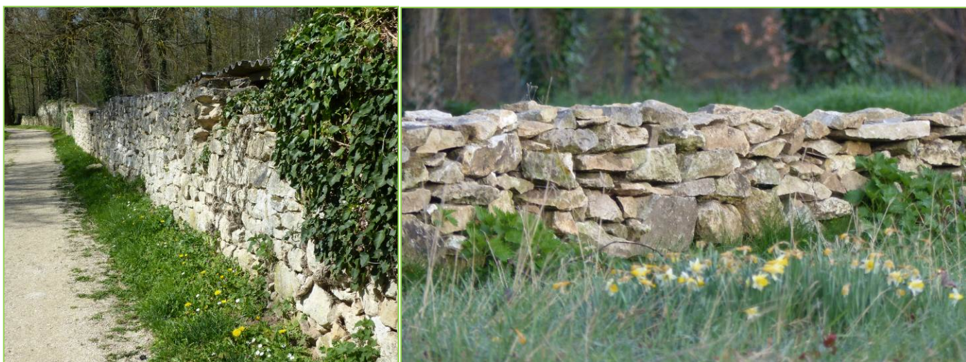
Figure 145 – Mur au sud du Golf et muret de pierres sèches sur le parcours de Vineuil, favorables au Lézard des murailles et aux petits mammifères (notamment) © O. Roquinarc'h, 2017.
