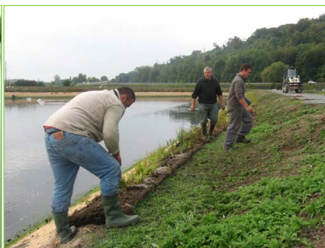
Figure 173 – Installation de nattes d'hélophytes prévégétalisées © marcanterra.fr – Photographie prise hors site.
