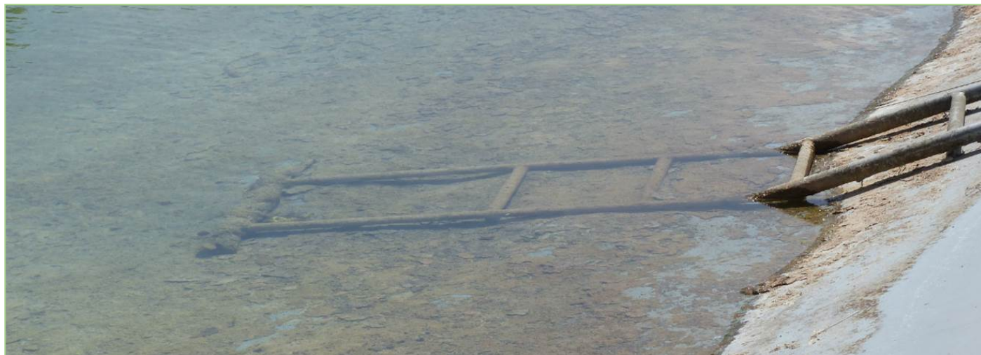
Figure 190 – Ce type de dispositif de sécurité n'est pas toujours suffisant pour éviter la noyade d'ongulés comme le Chevreuil, le Cerf ou le Sanglier. Il arrive également que des petits mammifères se retrouvent piégés dans les bassins bâchés, incapables de s'agripper aux matériaux lisses. L'installation de plusieurs types de dispositifs à différents endroits du bassin reste la solution la plus efficace pour éviter les noyades © O. Roquinarç'h, 2017.
