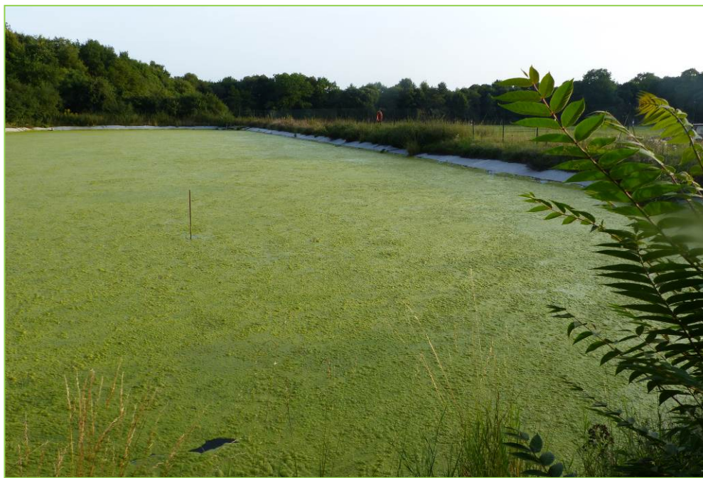
Figure 187 – Prolifération d'algues dans le réservoir de stockage d'eau © O. Roquinarc'h, août 2017.
