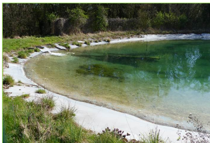
Figure 186 – Réservoir de stockage d'eau © O. Roquinarç'h, mars 2017.
