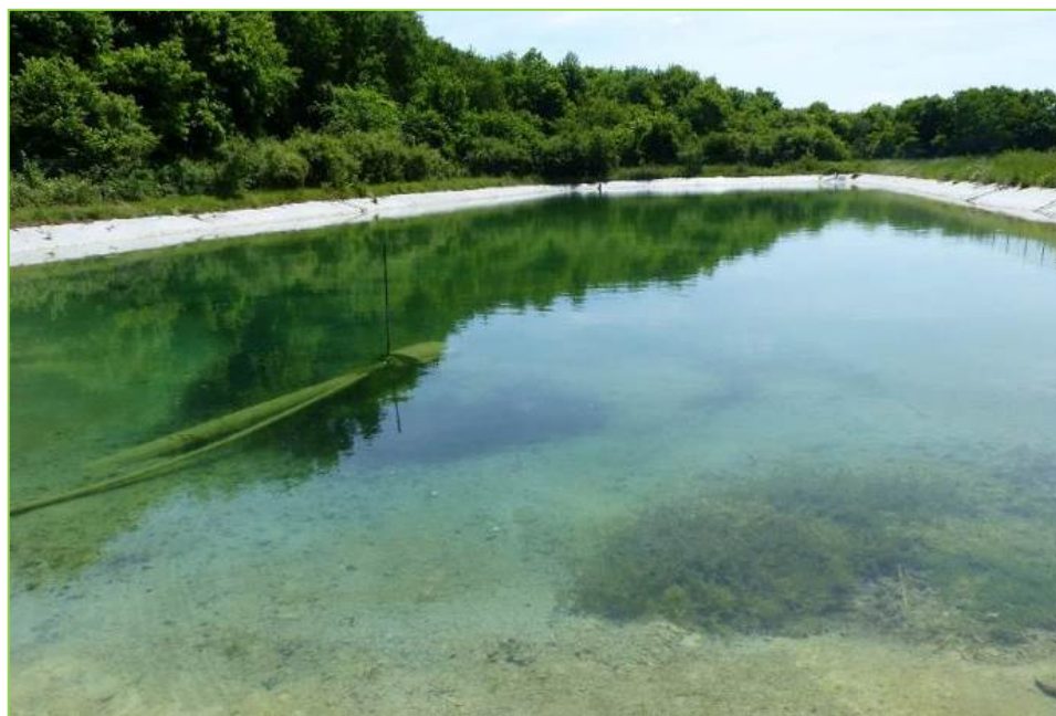
Figure 66 – Réservoir de stockage d'eau situé à l'entrée du Golf © O. Roquinarç'h, 2017.
