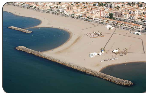
Enrochements et urbanisation des plages méditerranéennes © EID Méditerranée
