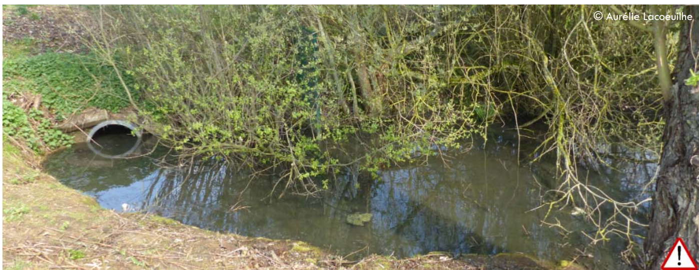
Figure 130 – Déversement des eaux des locaux techniques dans le ru du fossé de l’Aigle au nord du site (avril 2019).
