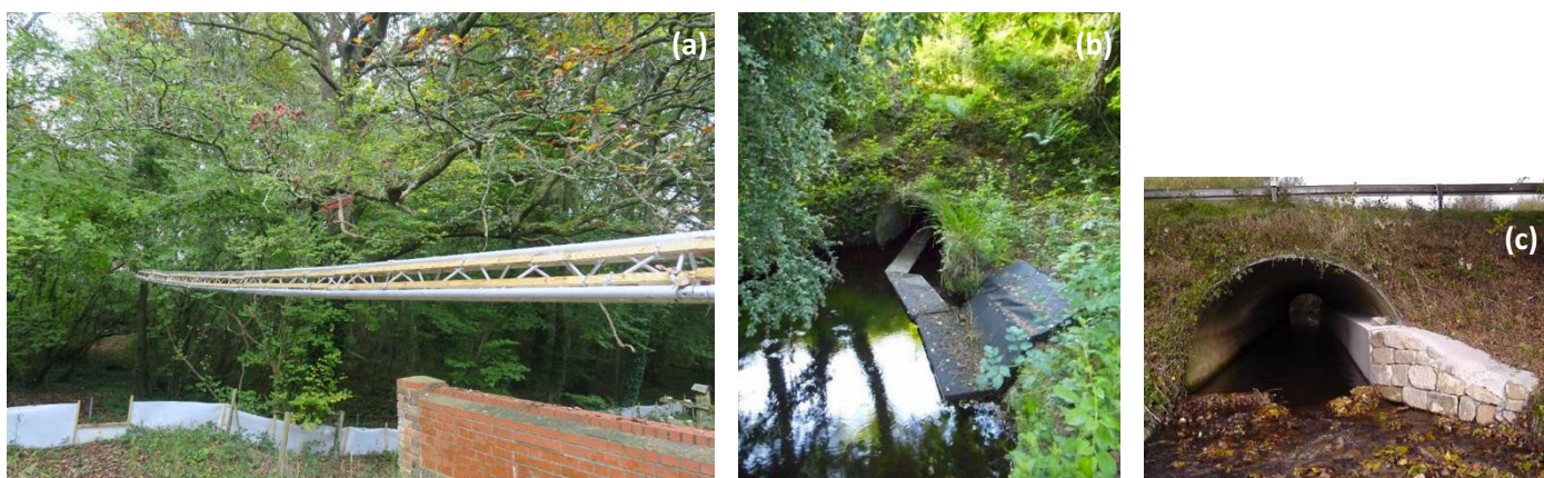
Figure 15. Illustrations de différents aménagements mis en place en Bretagne : (a) passage à petits rongeurs, (b) banquette à loutre et (c) ponton flottant © Groupe Mammalogique Breton
