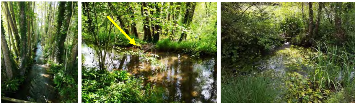
Figure 16 : cours d'eau incisé vraisemblablement curé durant les projets d'aménagement de la vallée des Beunes (photo de gauche, près du secteur « bas-marais » 44°55'50.19"N - 1° 4'23.14"E), canal de dérivation avec une fuite (photo du milieu, fuite indiquée par une flèche jaune, secteur « bas-marais » 44°55'1.73"N - 1° 6'2.79"E localisation approximative) et dérivation « naturelle » du cours d'eau dans la vallée qui imbibe en surface les zones humides adjacentes (photo de droite, secteur « observatoire » 44°56'43.58"N - 1° 5'9.12"E).
