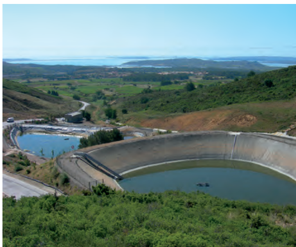
Figure 41. Exemple de bassin bâché avec des berges très abruptes, mais équipé d'un dispositif de type « échappatoire à faune » (en clair, au fond).
