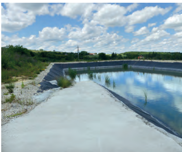
Figure 42. Exemple de bassin d'eau pluviale bâché, partiellement végétalisé avec une rampe en béton permettant l'accès de la faune et constituant une échappatoire.
