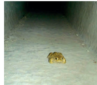
Figure 39. Exemple de fossé très fragmentant et défavorable à la biodiversité : pentes verticales, en béton, profondeur de plus d'un mètre, longueur totale de 300 mètres, pas de végétalisation et observations de nombreuses espèces piégées (Couleuvre à échelons Zamenis scalaris et Crapaud calamite Epidalea calamitas ).
